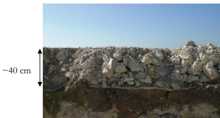
Photo 1 : Type de remblais utilisés pour le renforcement des chemins d'accès (Source : BE Jacquelin et Chatillon)
